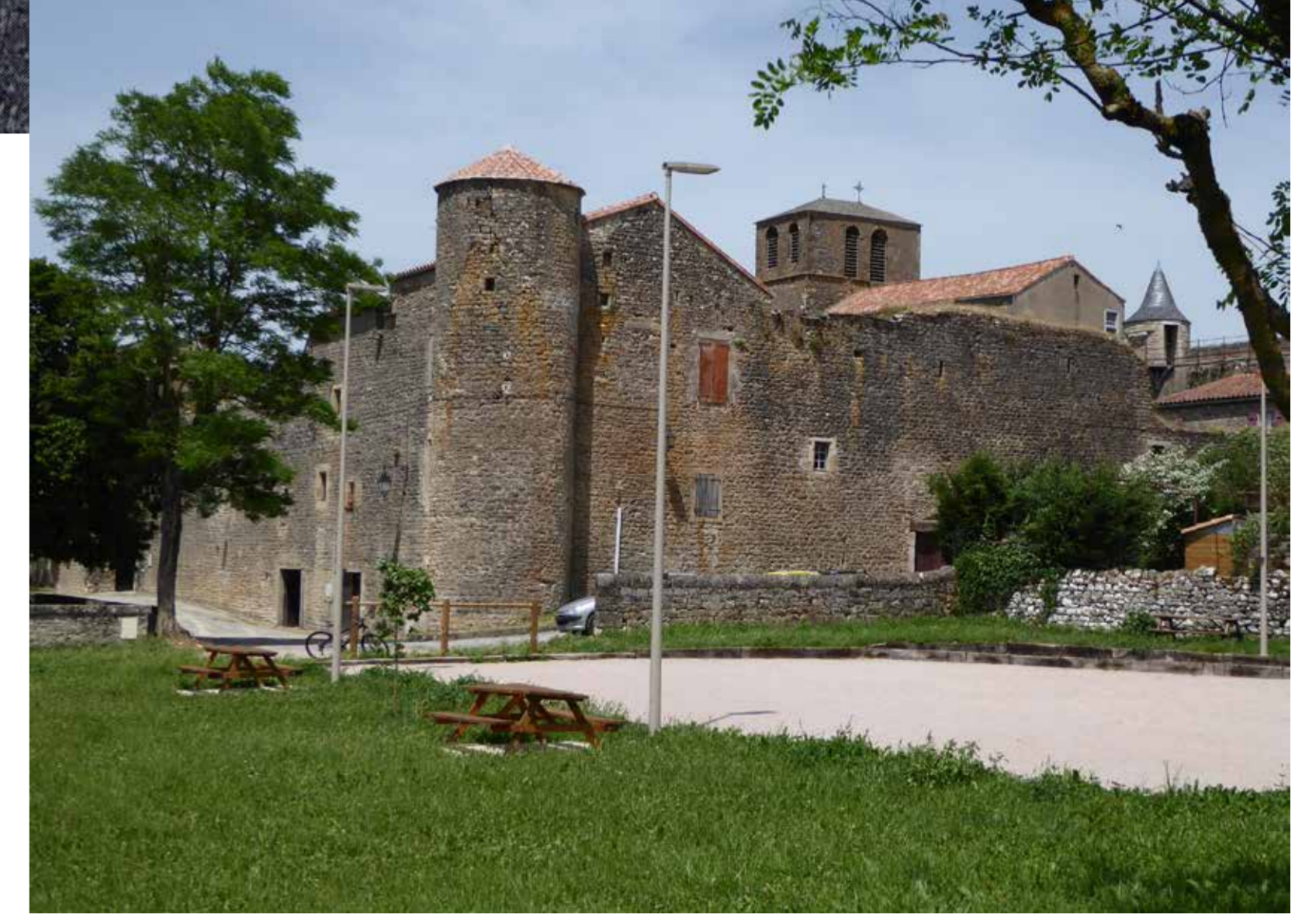
Angle Sud-Est du fort. C. Cazelles.
