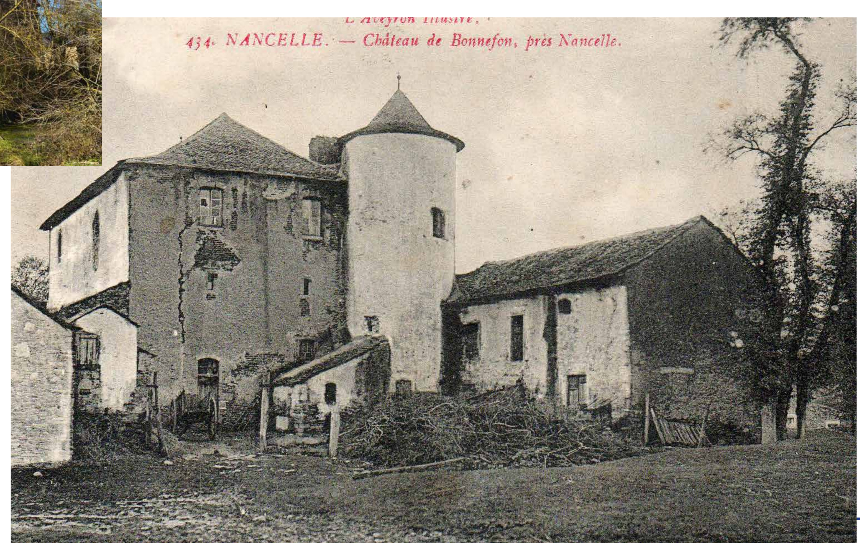
Façade principale Sud. Coll. part.
