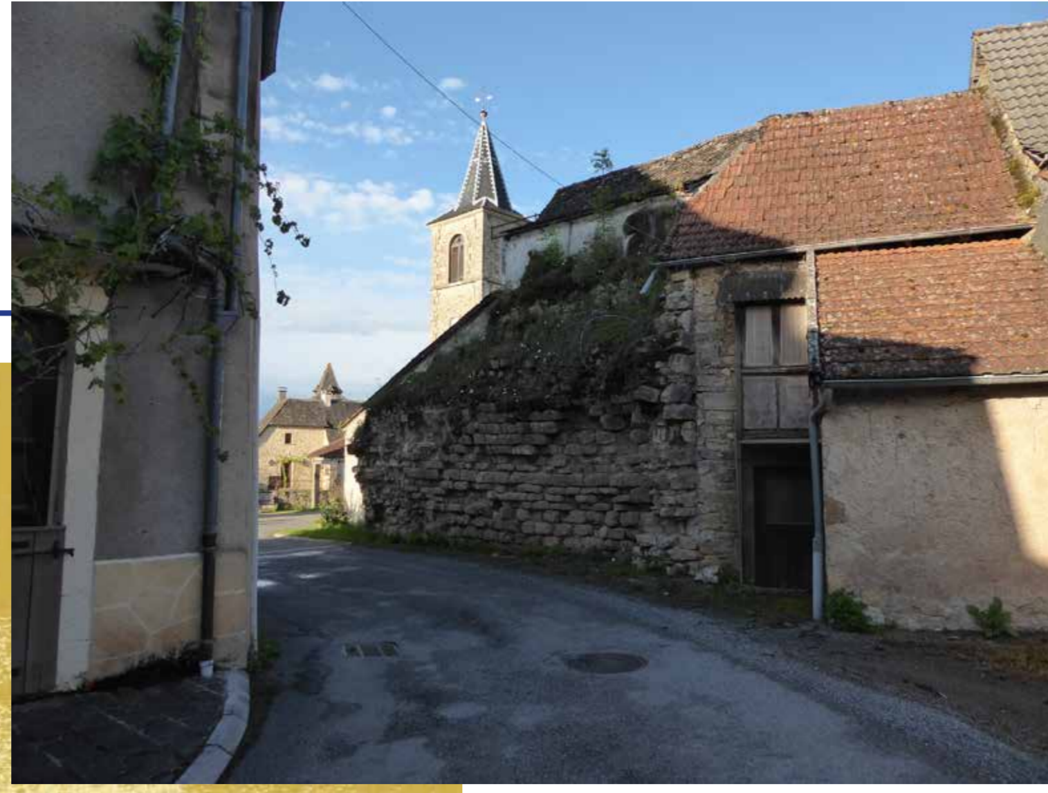
L'emplacement du passage voûté d'entrée de la cour démolit en 1936. C. Cazelles.
