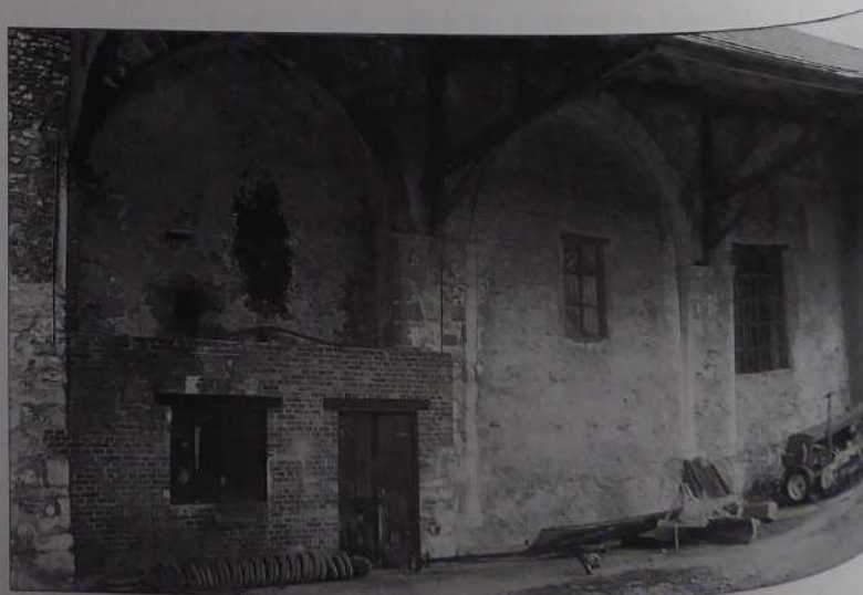
1. Saintines. Grange de Fay (Chaalis). Elévation est, premières travées sud ouvrant sur le collatéral détruit. © Bernard Rochon.
