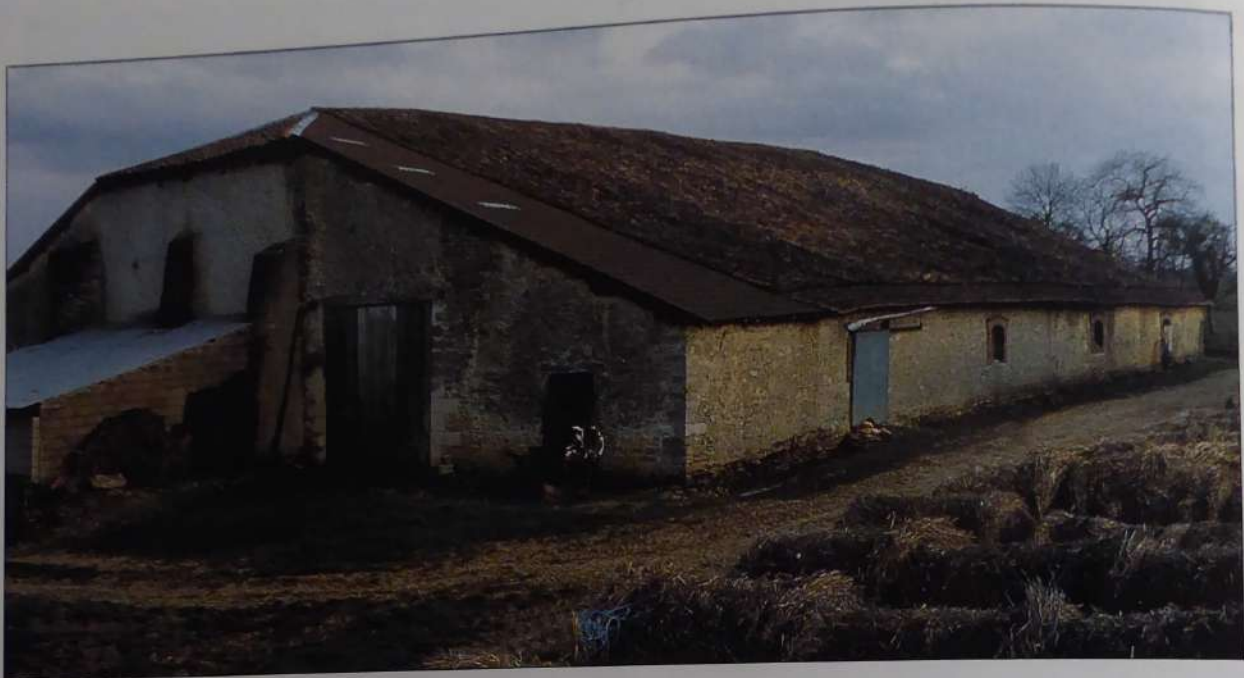
8. Unienville : Le Breuil, vue générale de la grange à partir du nord, avril 1991. © J. Fusier.
