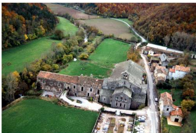
Vue d'avion, côté Est, Rodair 1992 Archives UDVAP 12
