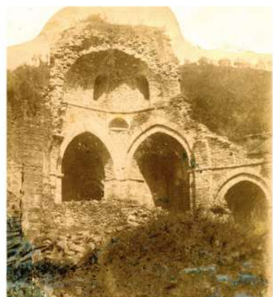
Intérieur de l'église du XII e . Effondrement de la coupole. Archives abbaye d'Aiguebelle.
