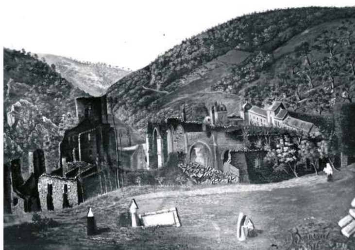
Peinture réalisée à Bonneval, par une des moniales ayant participé à la refondation de Bonneval. La vue est prise du Nord. On reconnaît au centre le chœur de l'abbatiale datant du XVI e siècle. En arrière-plan, on reconnaît les deux pavillons qui subsistent. Le corps de bâtiments qui les jouxte à l'Ouest a abrité la communauté dans les premières années. On remarquera que la peinture omet les tours d'enceinte. Archives de l'abbaye de Bonneval.
