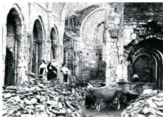
Sans doute entre 1875 et 1896. Déblaiement de la nef de l'abbatiale par les sœurs et des ouvriers locaux. Ces derniers sont de dos, chapeau sur la tête, près du char. La photographie est prise de l'Est. Elle montre les collatéraux, quelques chapiteaux, et le début de la voûte de la nef. Archives de l'abbaye de Bonneval.
