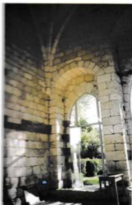
Intérieur de la façade de la porterie.
