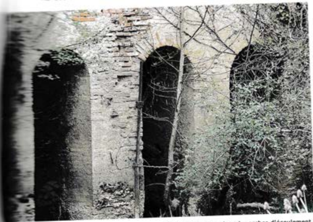
Le moulin de Planselve : les arches d'écoulement.
