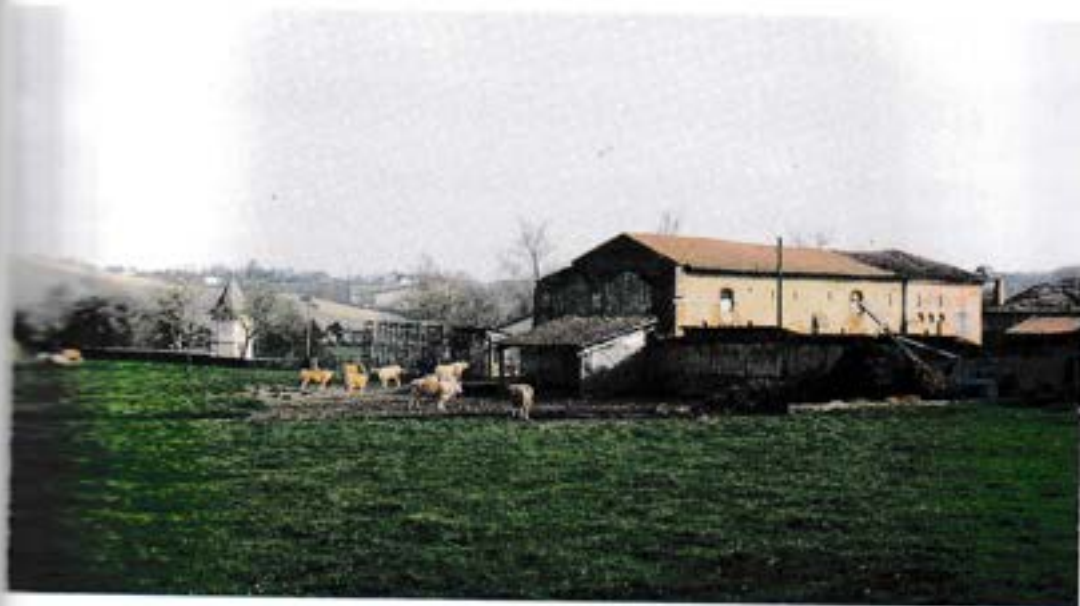
Le bâtiment principal des convers, autrefois entre l'église et la porterie intérieure. A l'étage, leur dortoir.
