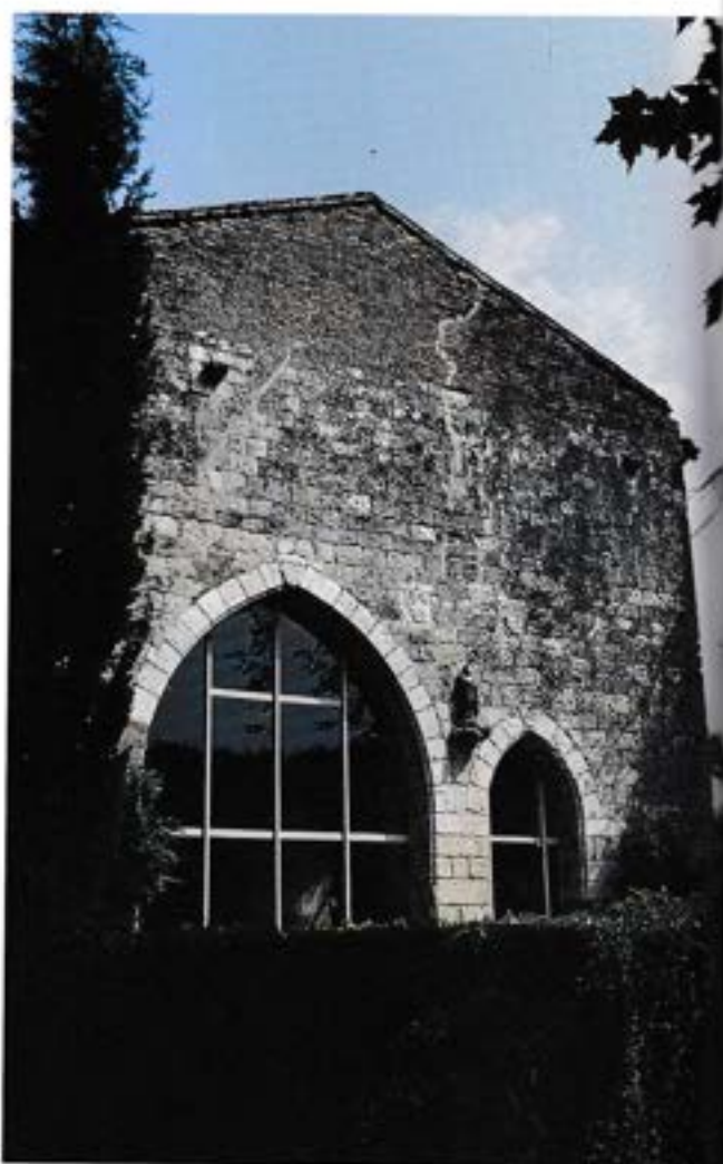
La porterie, avec ses deux ouvertures, la grande pour les charrettes, la petite pour les piétons.
