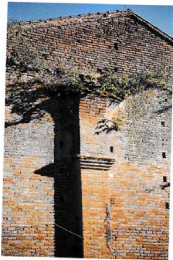
Détail du haut d'un pilier et amorce de la courbe.
