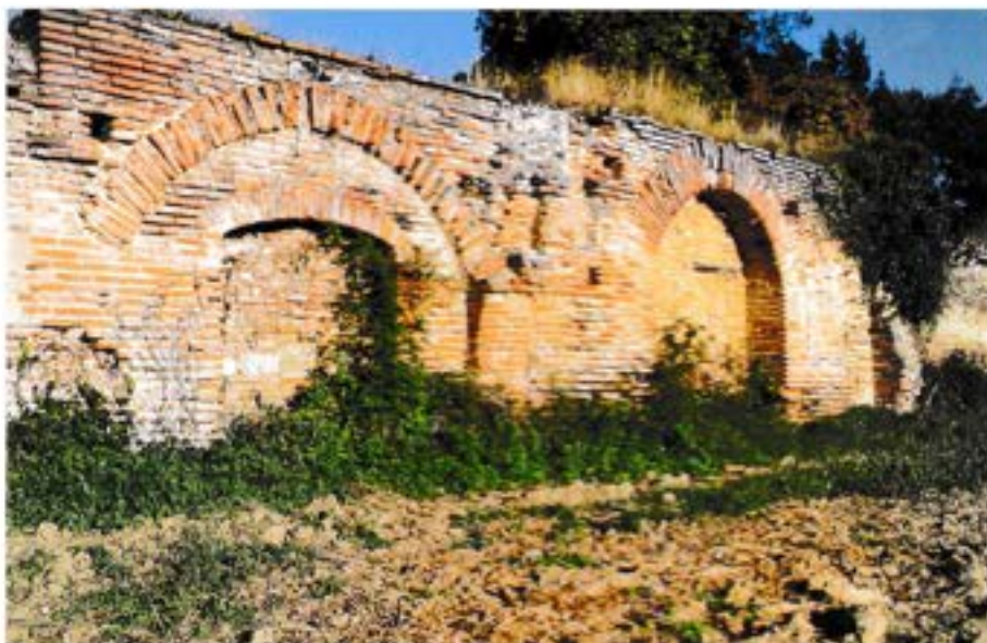
Ce qui reste de la façade de Notre-Dame des Neiges, vu de l'intérieur.
