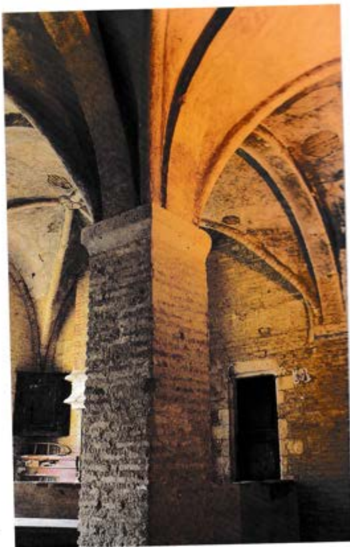
Les voûtes s'appuient sur les murs et sur des piliers centraux (on en voit un, ici, apparent).
