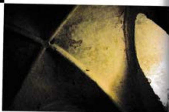
Deux vues de la fenêtre à ébrasement et de la voûte à tores, moulures de forme arrondie.
