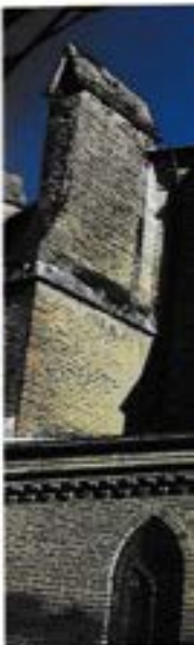
Eglise paroissiale Le haut des cor
