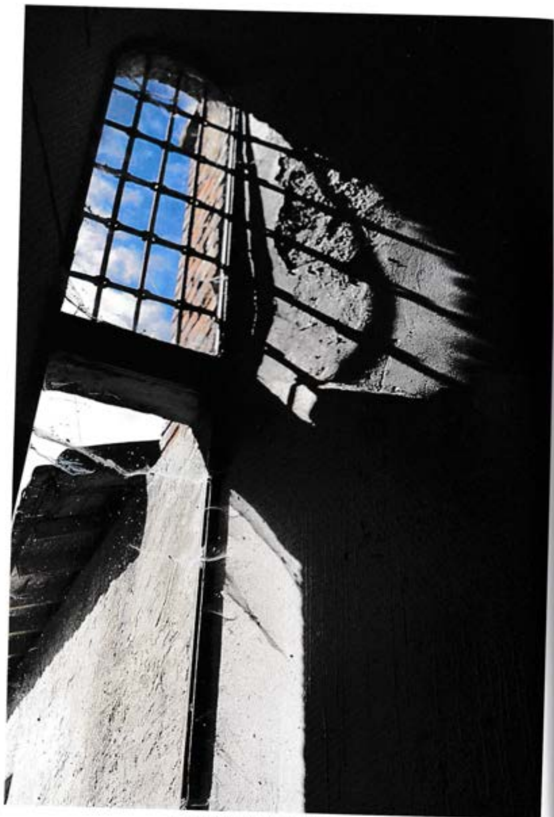
Fenêtre à grille de l'aile des convers.
