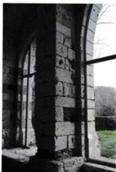
Au mur, gonds de l'ancienne porte en bois et creux pour bloquer la barre de fermeture.
