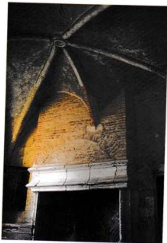
Cheminée avec arc de décharge dans le bâti de la hotte pour diminuer la poussée sur le milieu du linteau.
