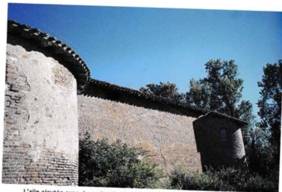
L'aile ajoutée avec, à gauche, l'extérieur de l'escalier menant au niveau bas et, à droite, la tour de pierre.
