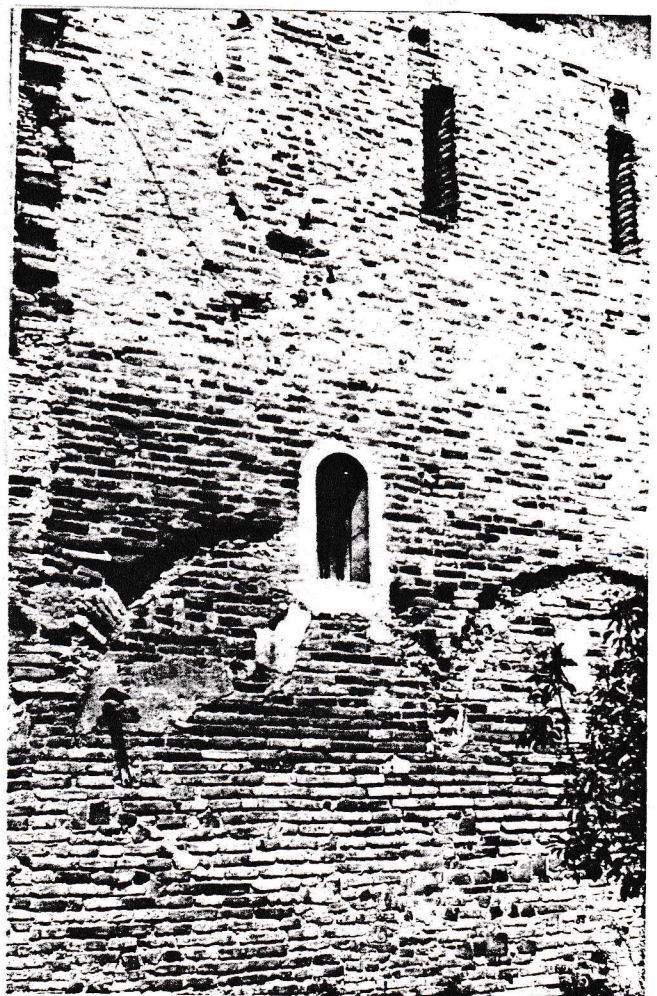
TRACES des anciennes voûtes du CLOÏTRE
