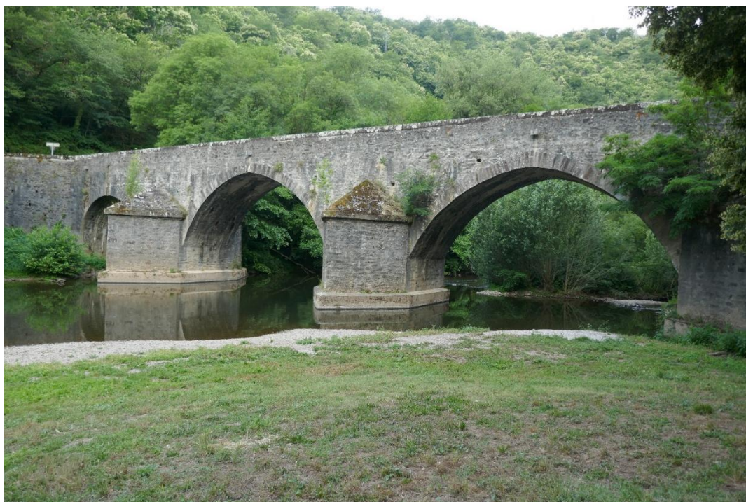
Le pont de Thuriès
